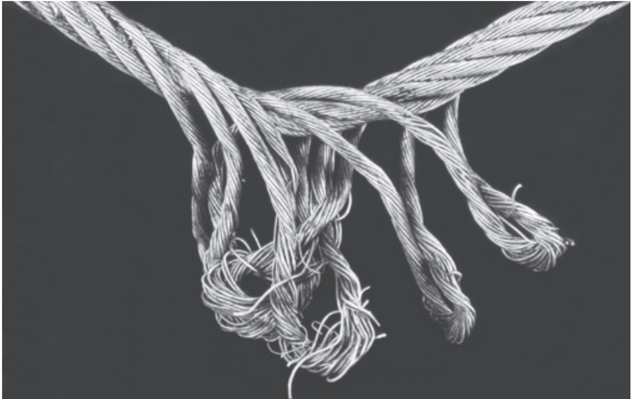
Rys. 37: Wzdłużna koncentracja nadmiarowa splotek zewnętrznych, spowodowana poprzez rozkręcenie liny stalowej.
