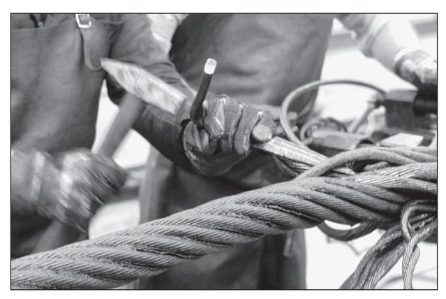
Fig. 31: Mise en place d'un épissoire au marteau
