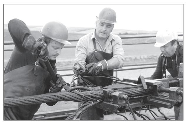
Fig. 34: Réalisation d'une épissure
